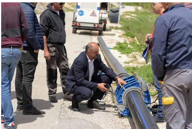
Radovi na vodovodnoj mreži u Rakitnu
