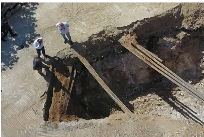
Radovi su iznimno zahtjevni
