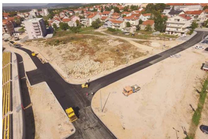
Nova prometnica olakšala je promet u užem središtu grada
