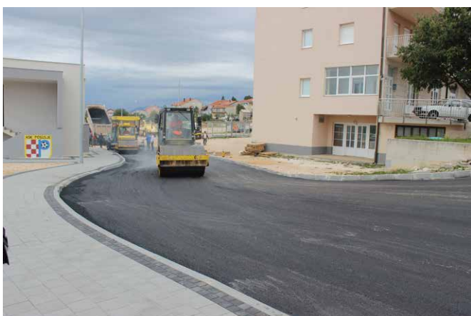
Asfaltiranje iznad Mokrog Doca
