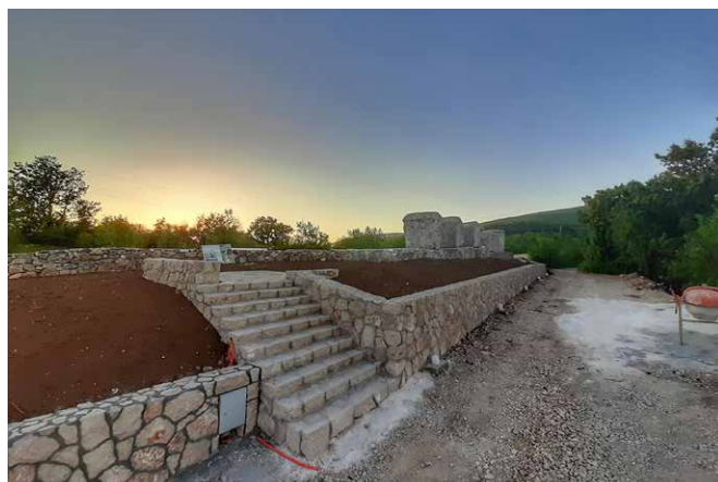
Podizanje potpornog zida koji će spriječiti dalje klizanje terena i pomjeranje stećaka na Ričini
