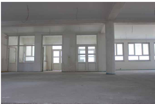
Unutrašnjost škole nakon odrađenih radova žbukanja
