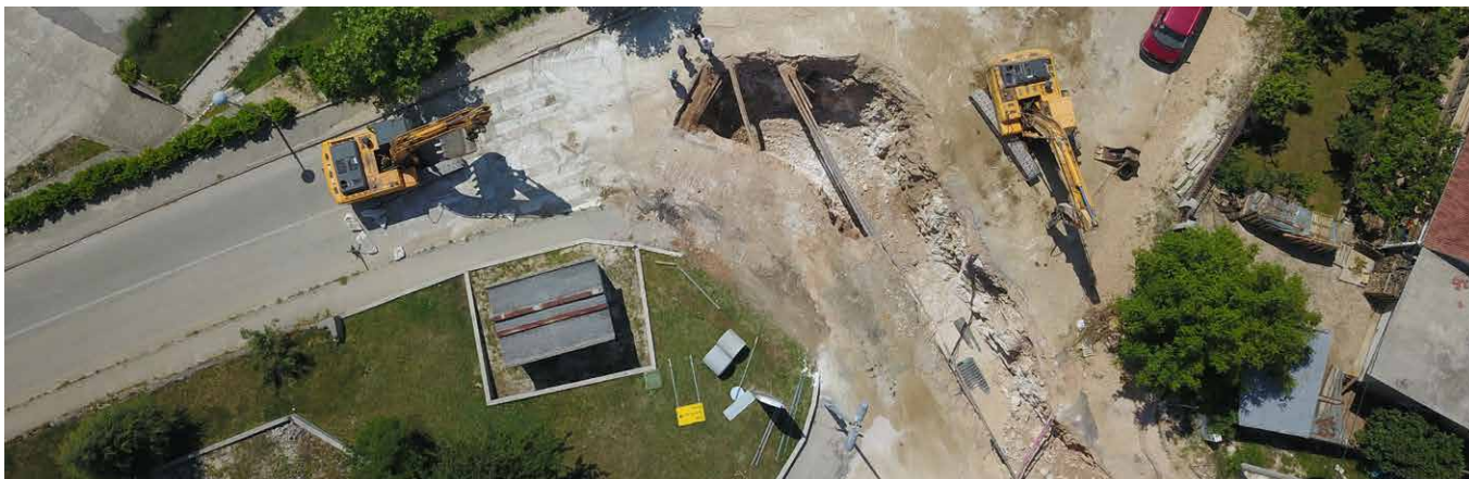
Radovi na kanalizacijskom sustavu
